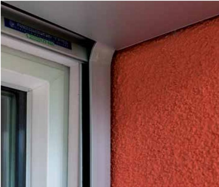
**Moderne.** Regacompact® est idéal pour remplacer les volets à rouleau existants, lors des travaux de rénovation et d'assainissement de bâtiments anciens. Installation avec caisson externe également possible. Disponible aussi avec des supports autoporteurs.
