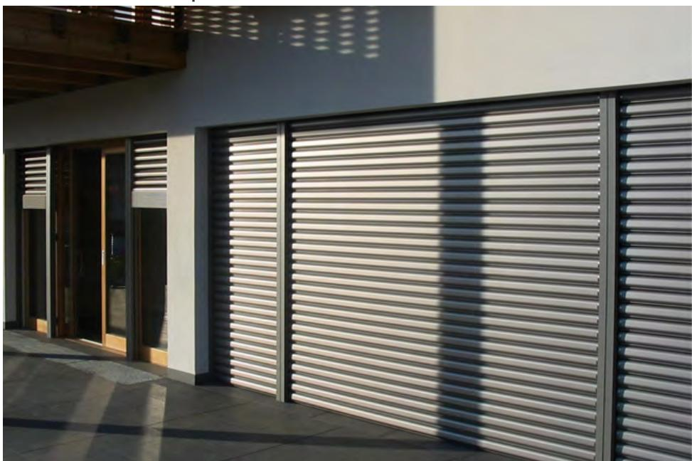
Store à lamelles d'extérieur, coulisses latérales autoportantes en aluminium extrudé et anodisé argent comprenant les mécanismes à balancier avec embrayage qui permettent l'orientation et la fermeture des lames.
